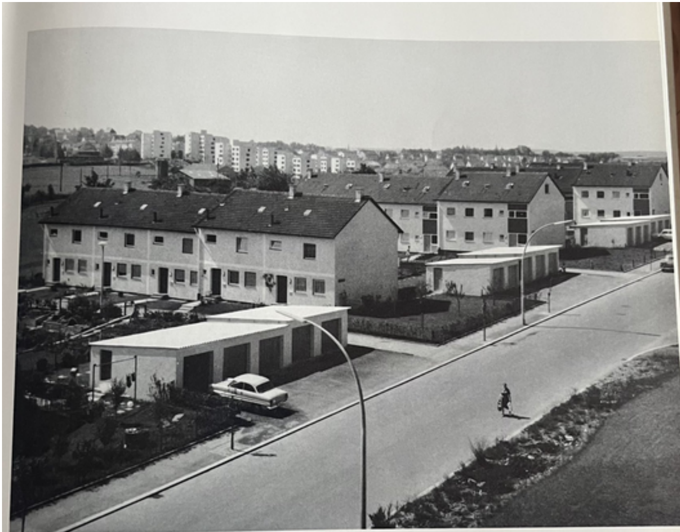
Bauvorhaben Sindelfingen-Goldberg von 1963—1966. Erstellt von unserer Gemeinnützigen Baugenossenschaft Stuttgart. Es handelt sich um verschiedene bewährte Grundrißtypen.
