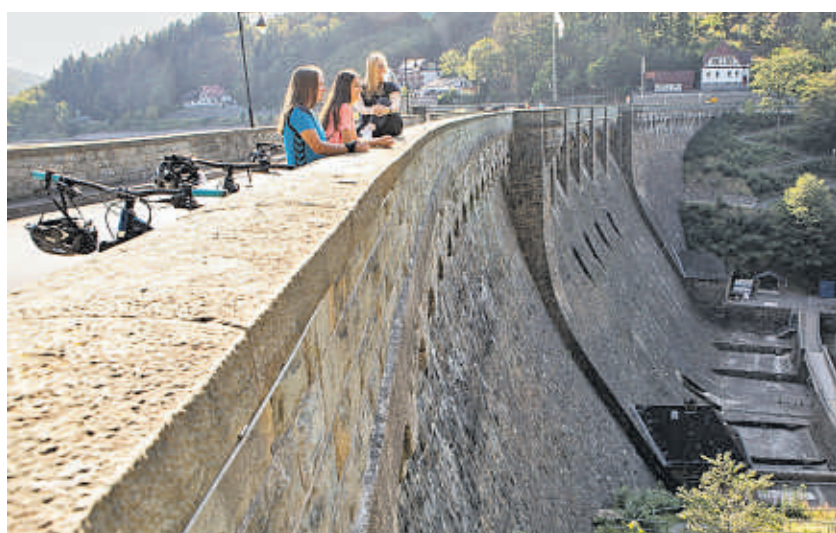
Der Diemelradweg bietet viel Natur, aber auch einige Sehenswürdigkeiten für kulturell Interessierte, wie die Diemeltalsperre, eine Staumauer am Diemelsee.
